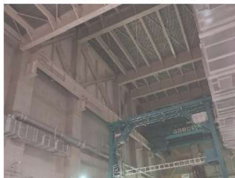
図 5.2.2 燃料取扱棟の屋根
