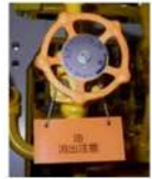
油類に係る弁 弁の識別
