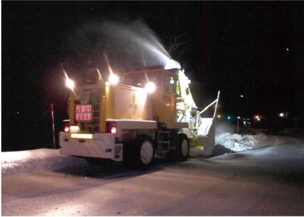
第4図 重機による除雪作業
