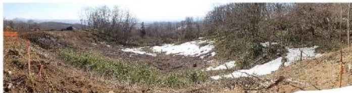
P3 防災科研調査において地滑り土塊とされる斜面の状況 防災科研調査において滑落崖とされる箇所から、地滑り土塊とされる箇所を見下ろす。 地滑り土塊を示唆する凹凸に富む緩斜面は認められない。
