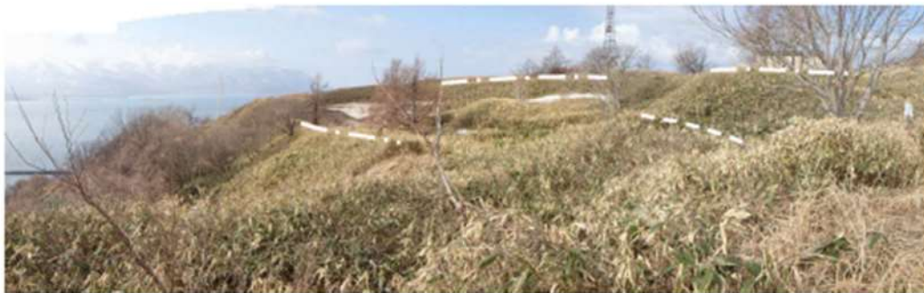
P6 防災科研調査において滑落崖とされる斜面の状況 滑落崖を示唆する遷急線及び遷緩線が認められる。
