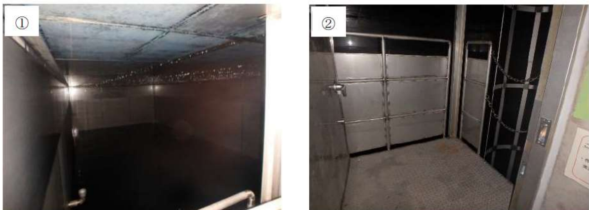
第 41-4-7 図：補助給水ピットの現場状況
