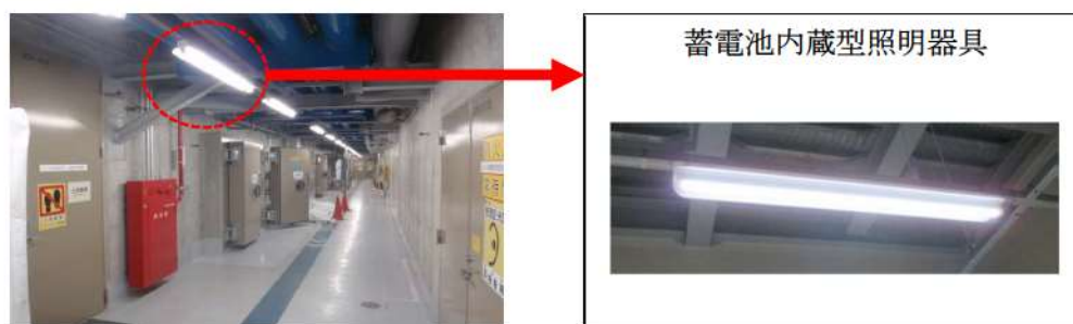
第 41-1-19 図：消火用非常用照明の設置例
