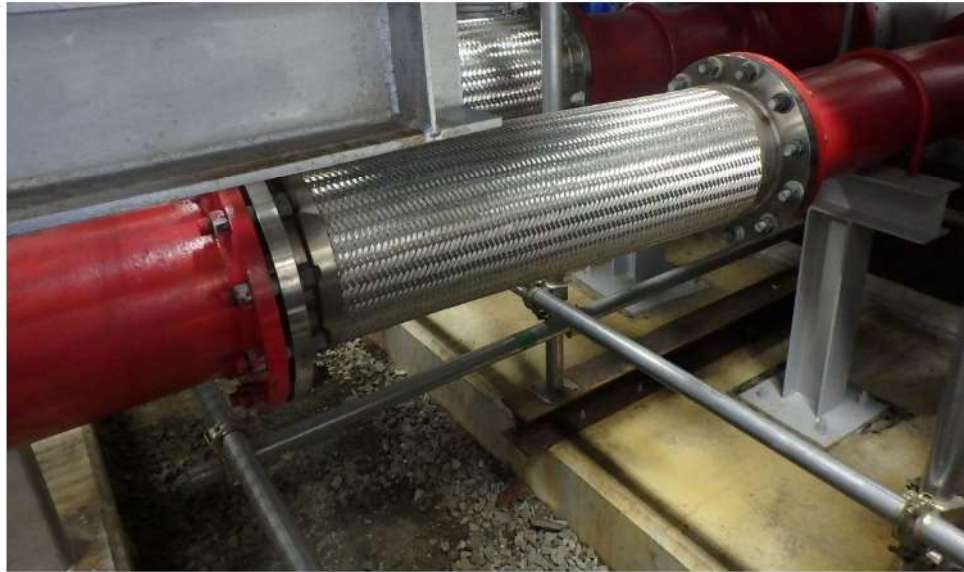
第 41-1-23 図 地盤変位対策の実施例
