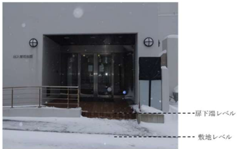
図3 建屋外壁扉（代表例）
