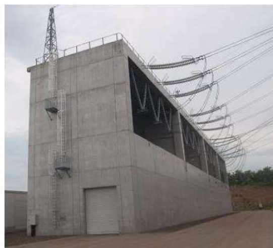
図1 開閉所（遮風建屋）
