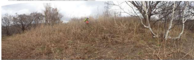
P4 防災科研調査において地滑り土塊とされる斜面の中腹部の状況 地滑り土塊を示唆する凹凸に富む緩斜面は認められない。
