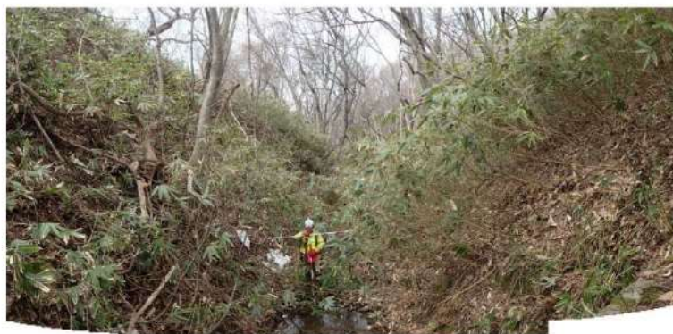
P3 防災科研調査において地滑り土塊末端部とされる箇所の状況
