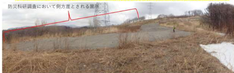
P3 防災科研調査において側方崖とされる斜面の状況 側方崖を示唆する遷急線及び遷緩線は認められない。
