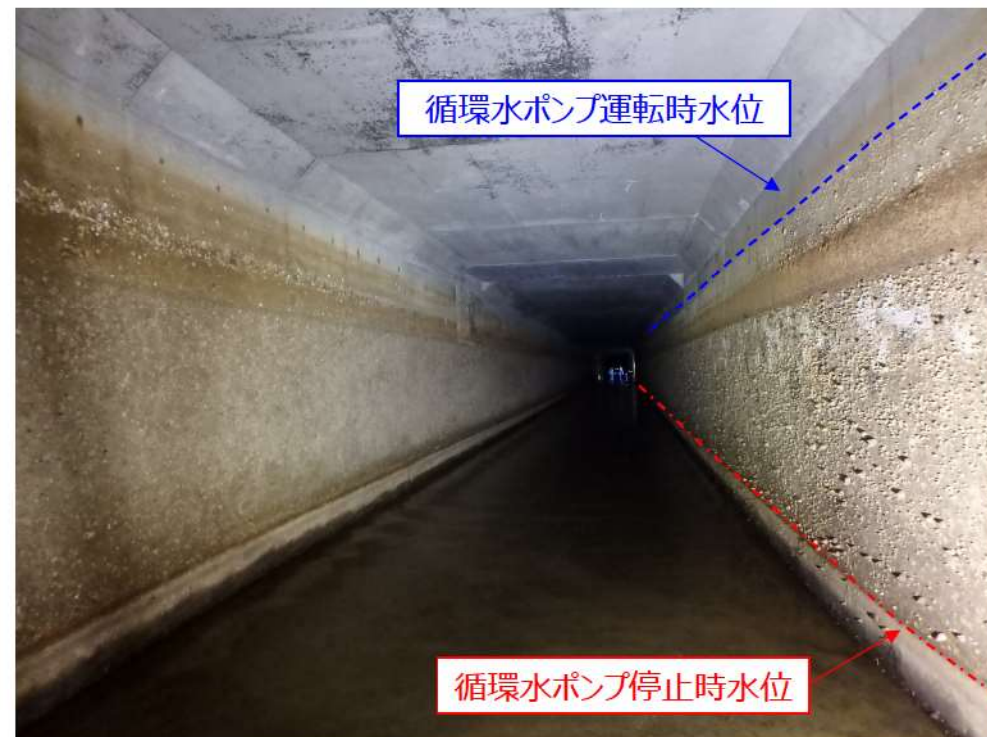
図1 1号炉放水路状況（2023年2月）
