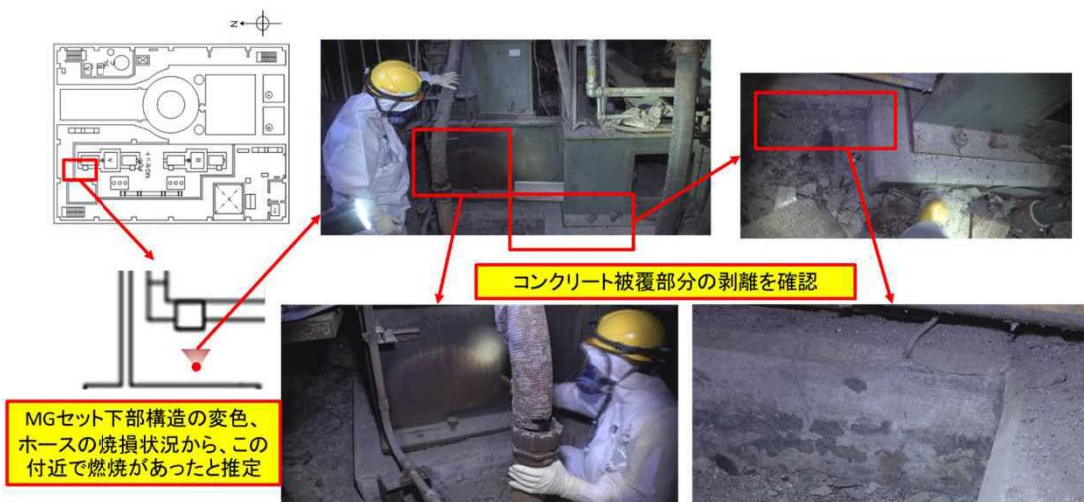
MGセット(A)の西側（下部構造及びコンクリート基礎）の状況
