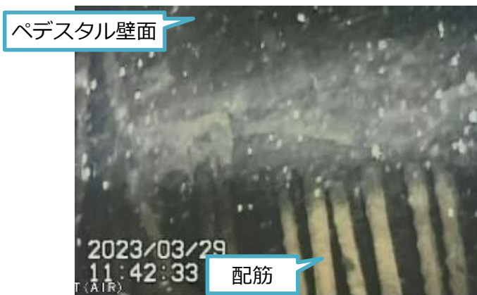
写真1. ポイント⑪ペDESTAL基礎部
