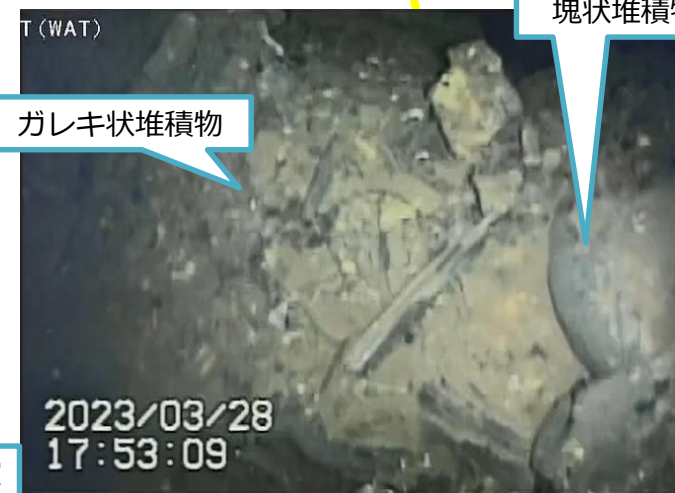
写真3.ペDESTAL内開口付近堆積物
