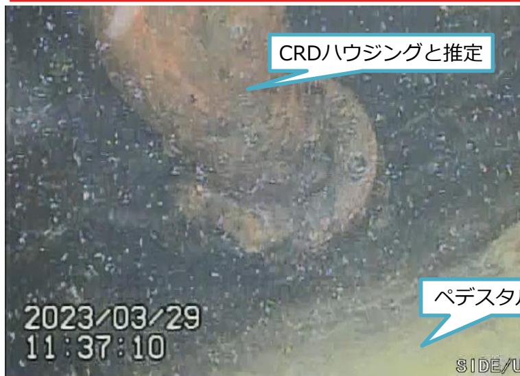
写真1. CRDハウジングと思われる構造物 (上部監視カメラで気中を撮影)
