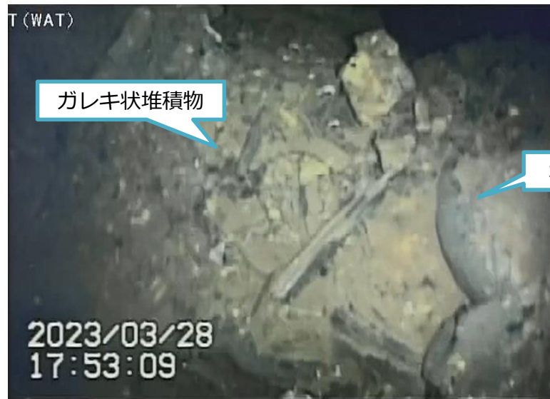
写真2.ペDESTAL内開口付近堆積物
