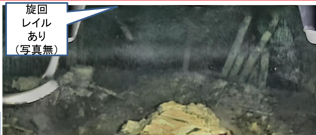
写真1. 1号機のペデスタル内の状況
