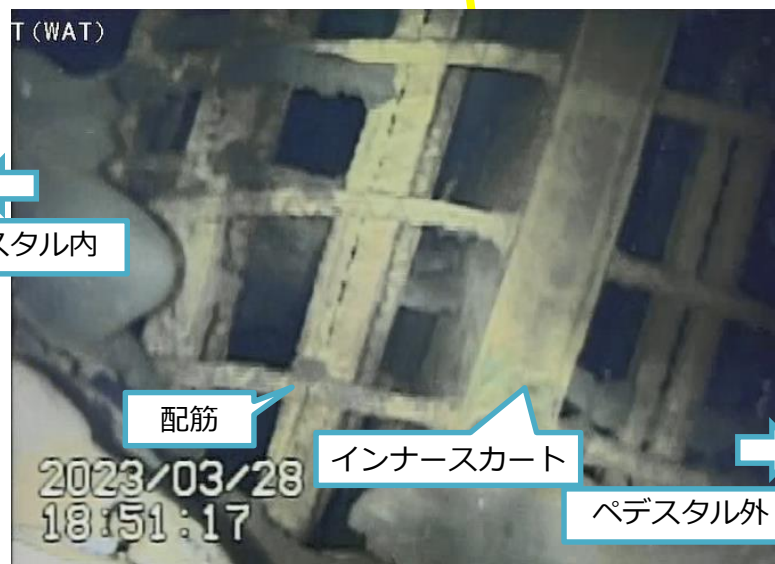
写真3.ペDESTAL開口右側配筋
