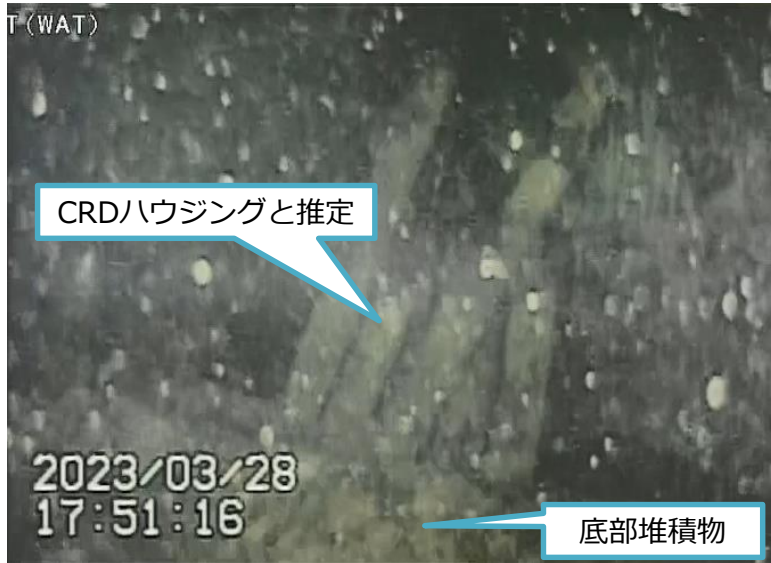
写真1. CRDハウジングと思われる構造物
