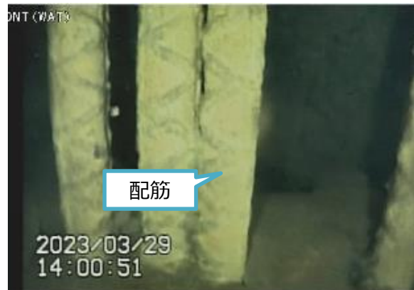
写真2. ポイント⑫ペDESTAL基礎部
