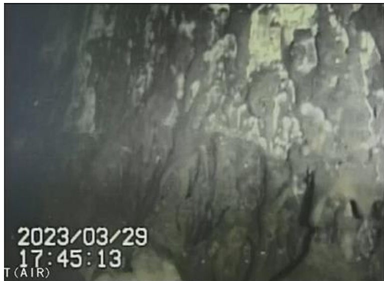
写真1 棚状堆積物のない壁面の状況
