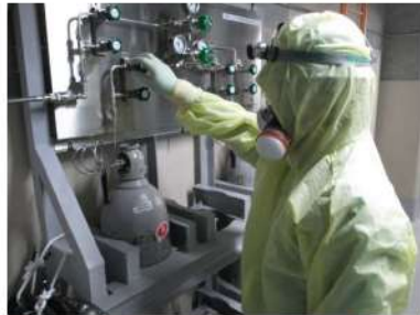
窒素供給操作 (バルブパネル操作)
