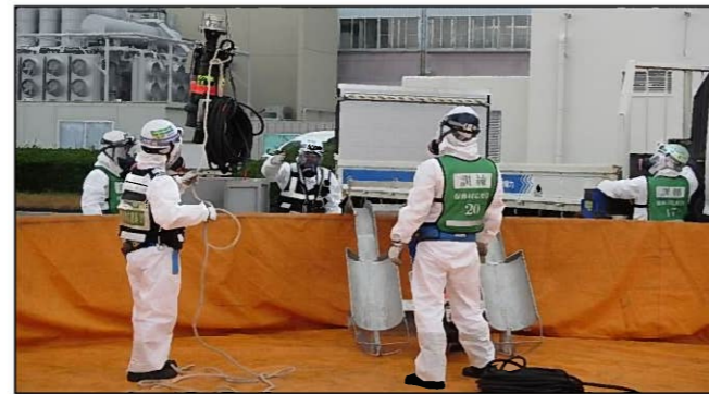
◇中間受槽(水槽)の設置
