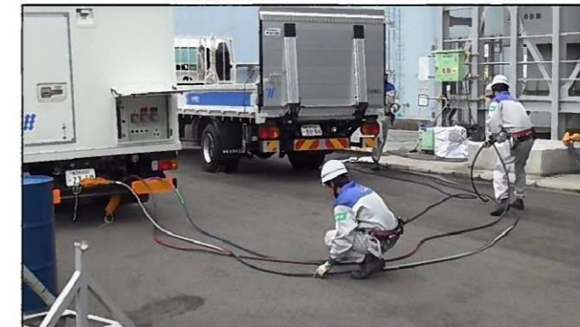
◇高圧発電機車へのケーブルつなぎ込み
