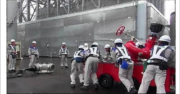
◇放水砲の設置
