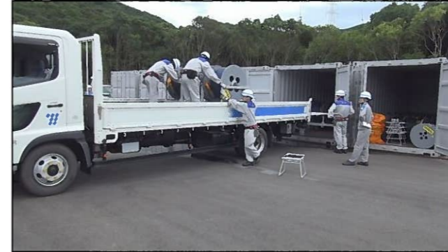
◇電源ケーブルの運搬
