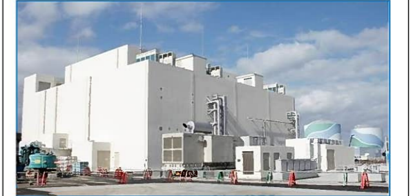
緊急時対策棟（指揮所）
