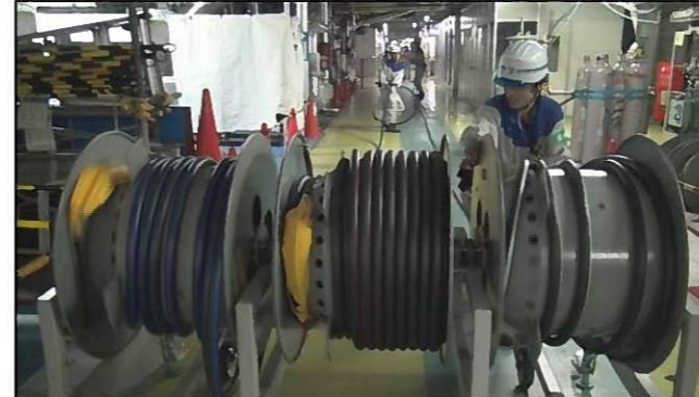
◇電源ケーブル布設(屋内)
