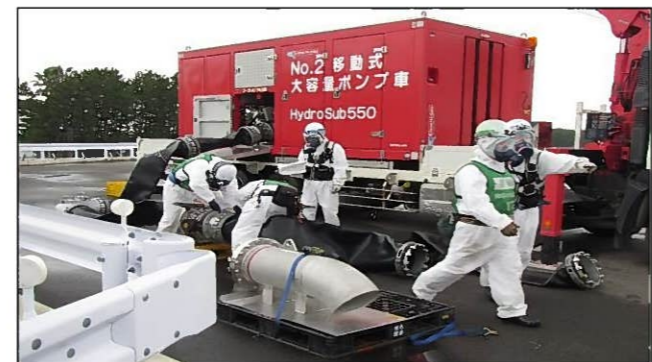
◇ホースの布設
