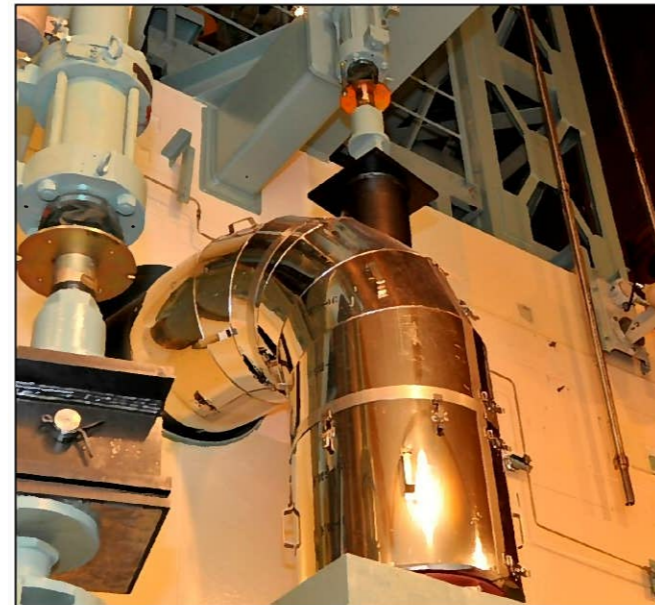
【配管のサポート補強】
