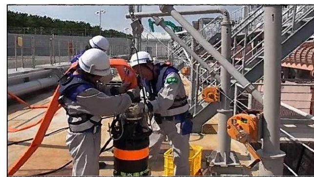
◇海水を取水するための水中ポンプ設置
