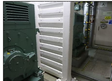
【耐火隔壁の設置】
