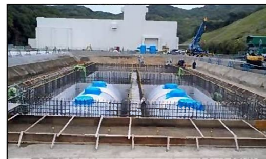
燃料油貯蔵タンク増設
