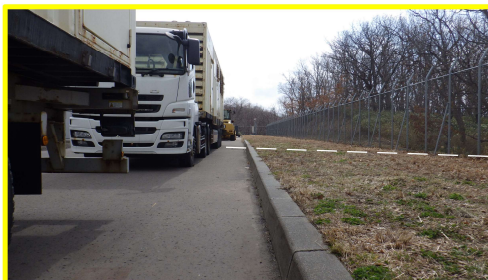
P6 開閉所周回道路の状況 防災科研調査において示される側方崖と地滑り土塊の境界に当たる。 当該箇所付近に地滑りを示唆する変状（縁石及びフェンスのずれ）は認められない。
