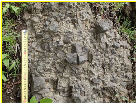
P6 防災科研調査において地滑り土塊北側端部とされる箇所付近の露岩状況 堅硬な岩盤（凝灰角礫岩）が認められる。
