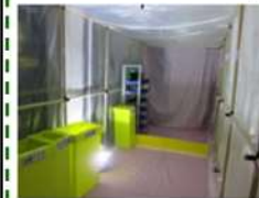
可搬型照明①
