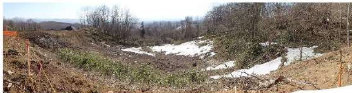
P3 防災科研調査において地滑り土塊とされる斜面の状況 防災科研調査において滑落崖とされる箇所から、地滑り土塊とされる箇所を見下ろす。側方崖を示唆する遷緩線及び遷急線や、地滑り土塊を示唆する凹凸に富む緩斜面は認められない。
