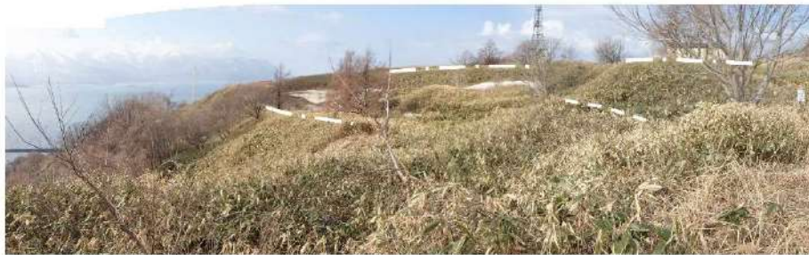
P4 防災科研調査において滑落崖～側方崖とされる斜面の状況 遷緩線及び遷急線が認められる。
