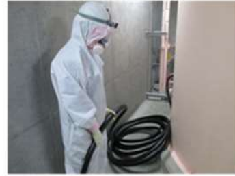
仮設ホース接続及び敷設 (ディーゼル発電機燃料油サービスタンク室) (原子炉建屋T. P. 17. 8m)
