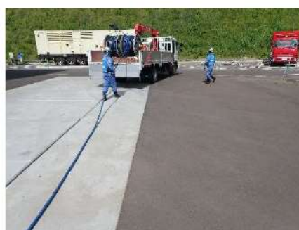
号炉間連絡予備ケーブル敷設 (屋外T.P. 31m)
