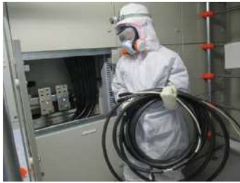
可搬型直流変換器 直流出力ケーブル敷設作業 (安全補機開閉器室) (原子炉補助建屋 T.P. 10. 3m)
