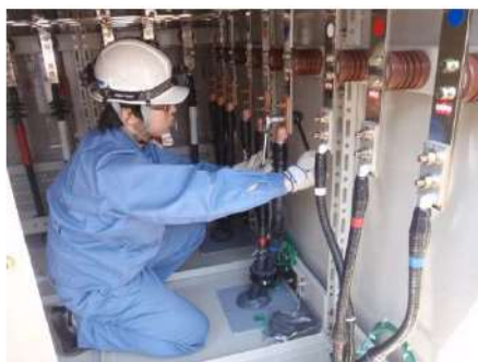
号炉間連絡ケーブル接続 （屋外T. P. 31m）
