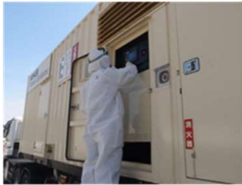
可搬型代替電源車起動 (屋外T. P. 31.0m)
