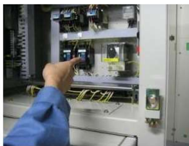
代替非常用発電機受電遮断器操作 (安全補機開閉器室) (原子炉補助建屋T. P. 10. 3m)
