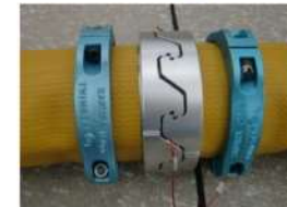
可搬型ホース（150A）接続後
