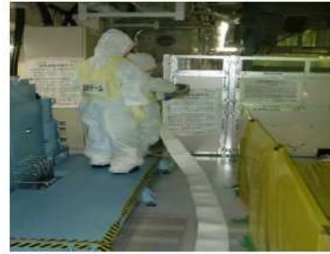
可搬型ホース敷設 (原子炉建屋 T. P. 33. 1m)
