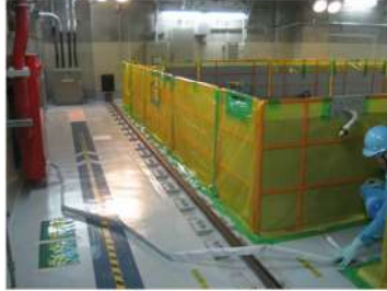
消防ホース敷設 (原子炉建屋 T. P. 33. 1m)
