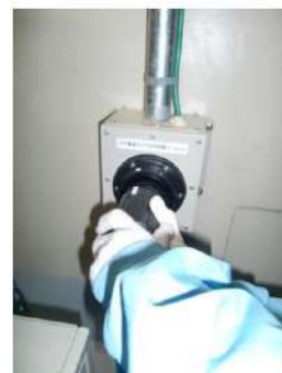
電源ケーブル接続
