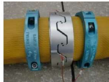
可搬型ホース (150A) 接続後
