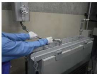
空冷配管との接続
