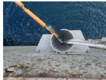
荷揚場シルトフェンス端部と 固定金具の接続状況
