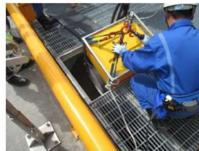
海水取水箇所への水中ポンプ設置
