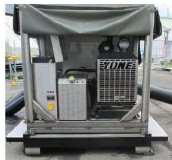
泡混合設備設置
