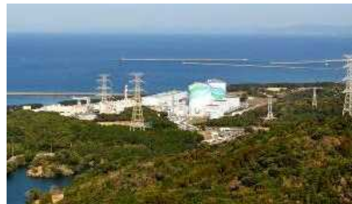
<川内原子力発電所>
