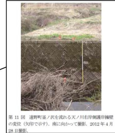
第11図 遠野町釜ノ沢を流れる天ノ川右岸側護岸擁壁の変位（矢印で示す）、南に向かって撮影。2012年4月28日撮影。
