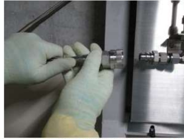
アンモニア全量排気弁作用可搬型 窒素ガスポンペのカプラ接続 (原子炉建屋 T. P. 40. 3m)
