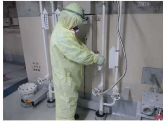
(制御用空気供給弁閉操作イメージ)
