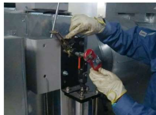
(空気作動ダンパ閉作業イメージ)
