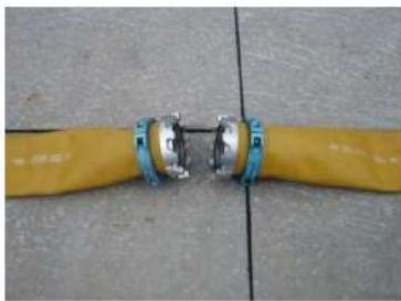
可搬型ホース (150A) 接続前
