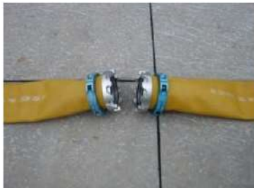
可搬型ホース (150A) 接続前
