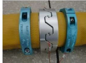
可搬型ホース (150A) 接続後
