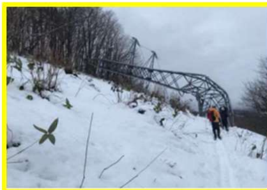
大雪による鉄塔倒壊事例 ※3
