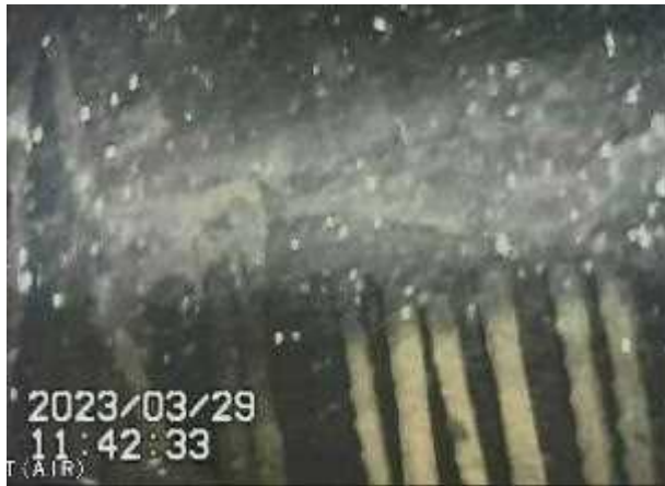
写真1. ポイント⑪上部
