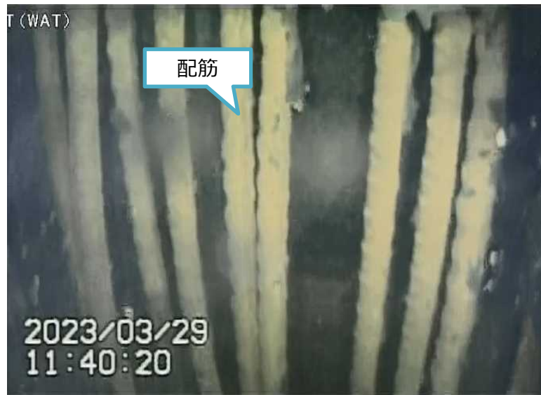
写真2.ペDESTAL内壁面部(下部)
