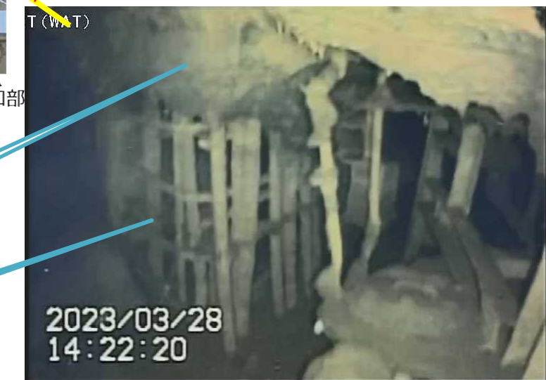
写真4.ペDESTAL開口部右下側壁面部
