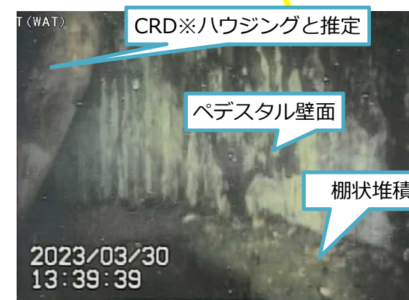
写真3. ペDESTAL内の棚状堆積物と壁面部
