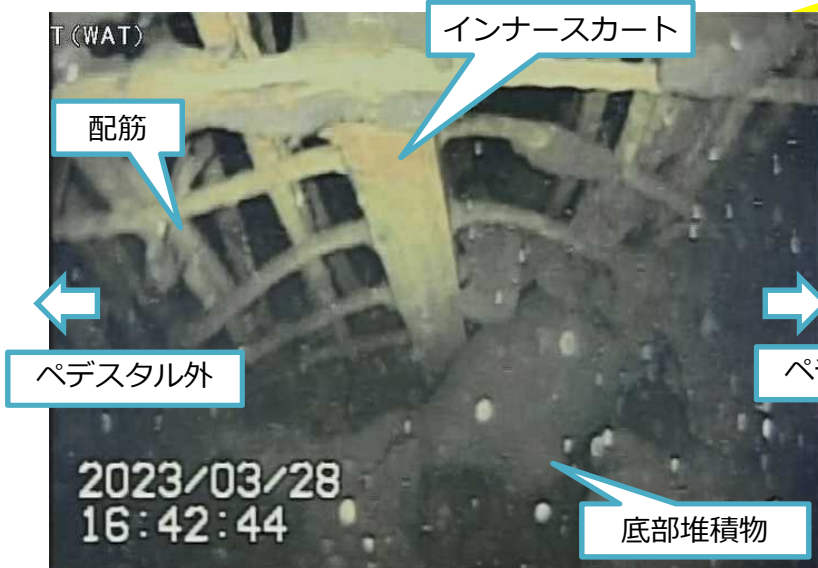
写真2.ペDESTAL開口左側配筋
