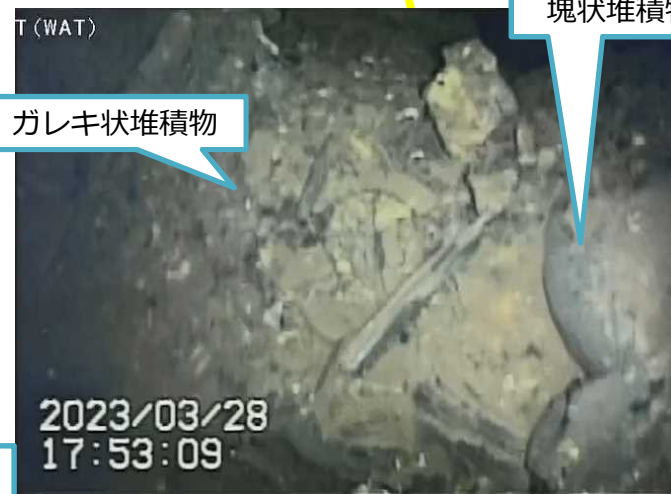
写真3.ペDESTAL内開口付近堆積物
