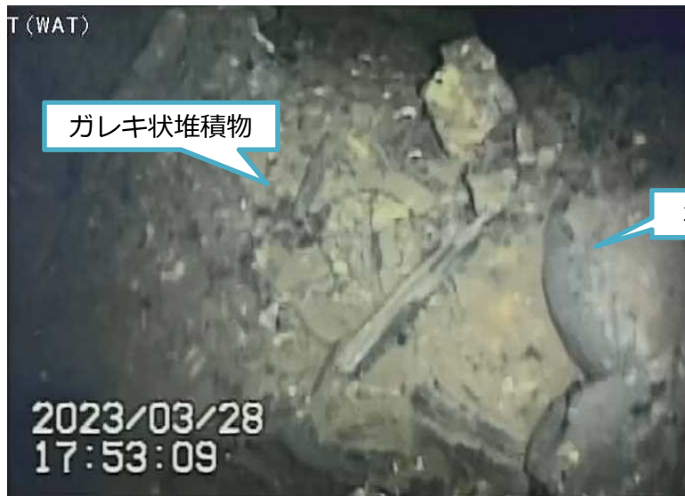
写真2.ペDESTAL内開口付近堆積物
