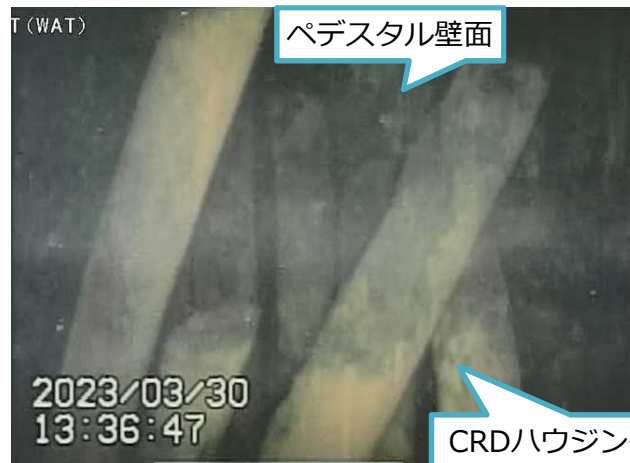
写真2. CRDハウジングと思われる構造物
