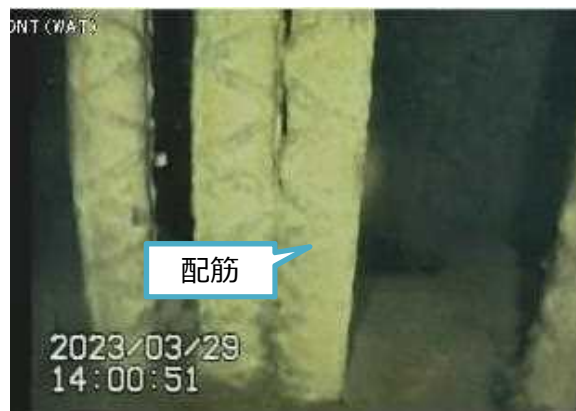
写真2. ポイント⑫ペDESTAL基礎部
