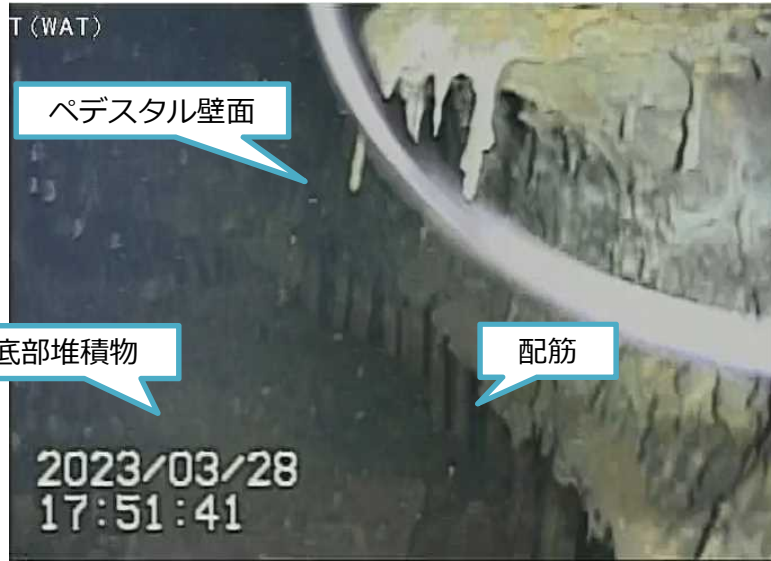
写真1.ペDESTAL内壁面部配筋
