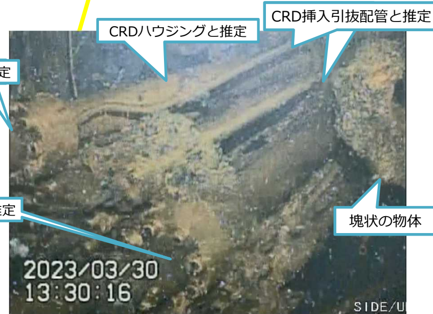
写真3. CRD関連と思われる構造物 (上部監視カメラで気中を撮影)
