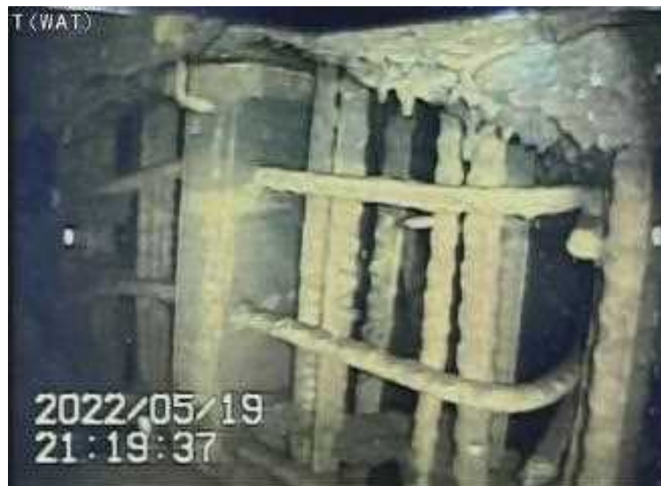
アクセス開口部付近 調査状況
