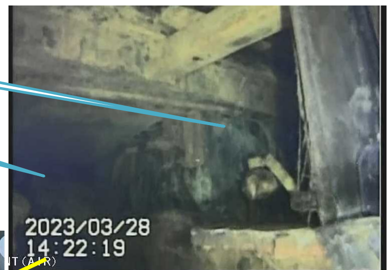
写真3.ペDESTAL開口部右上側壁面部
