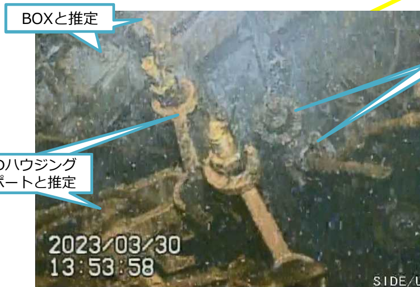
写真2. CRDハウジングサポートと思われる構造物 (上部監視カメラで気中を撮影)
