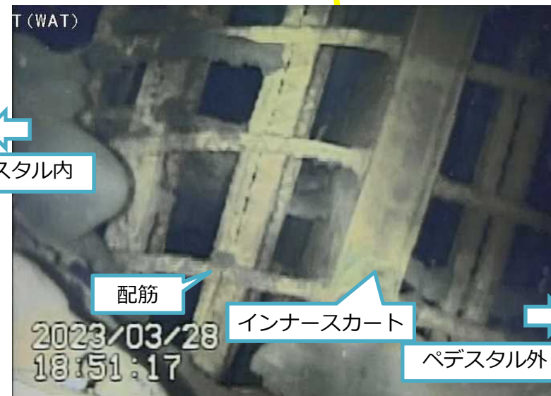
写真3.ペDESTAL開口右側配筋
