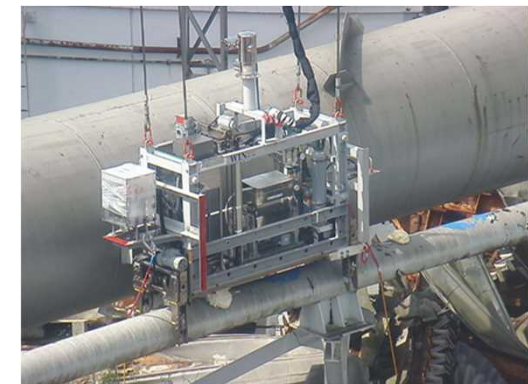
写真：2021年9月ウレタン注入時
