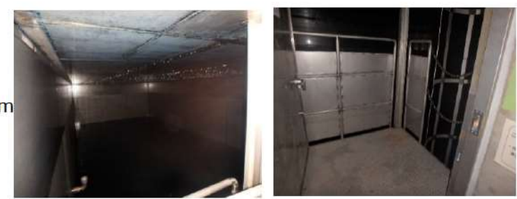
補助給水ピットの現場状況
