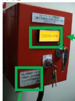
写真③ 放出ロック盤
