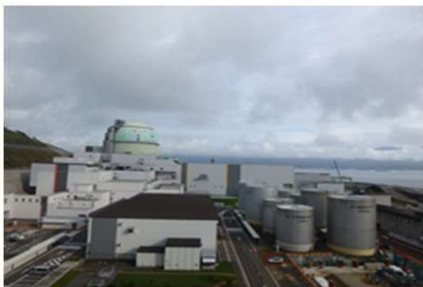
2号炉タービン建屋屋上
