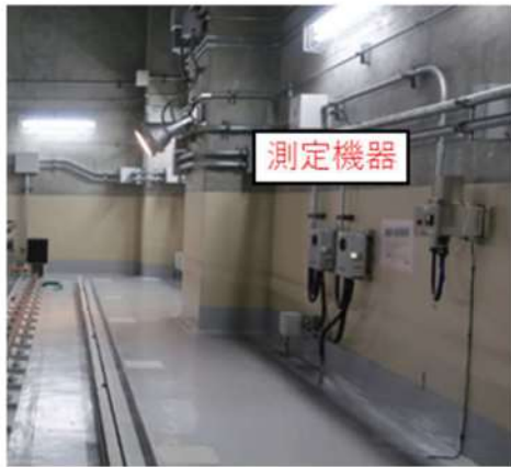
⑦使用済燃料ピット周り
