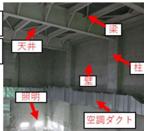
②使用済燃料ピット上部
