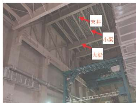
図 5.2.2 燃料取扱棟の屋根
