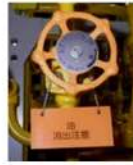
油類に係る弁 弁の識別
