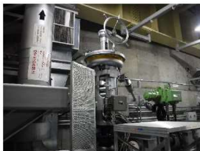
【図1 3B-主蒸気逃がし弁】
