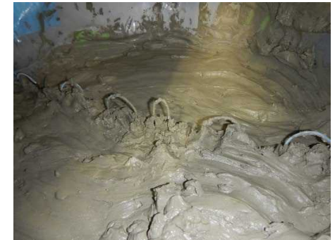
(2) 容器の内部状況
