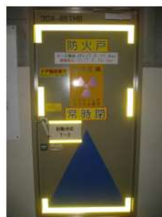
図 16 扉への反射テープ貼り付け例
