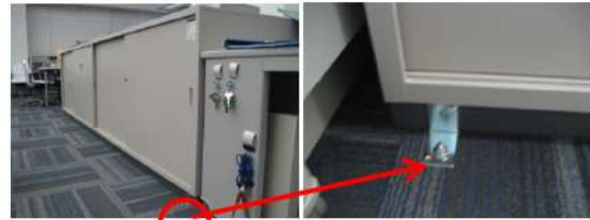
図 11 キャビネットの固定
