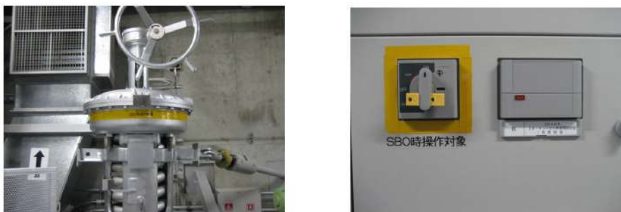
図 14 操作対象機器への反射テープ貼り付け例
