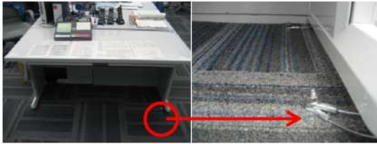
図 10 運転員机の固定
