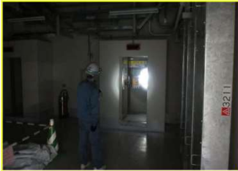
可搬型照明 (懐中電灯) を使用した状態
