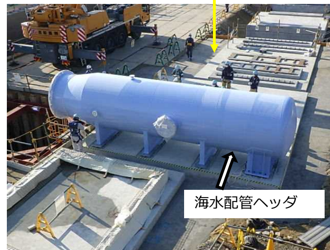
海水移送配管基礎構築・海水配管ヘッド設置の状況
