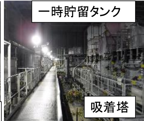
前処理設備 （薬液注入関連設備）
