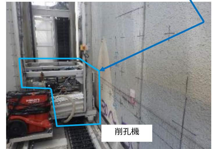
<現場削孔状況>
