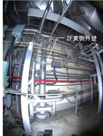
④2F東側外壁
