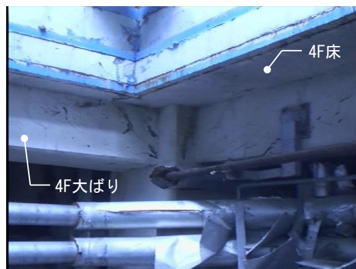
②4F大ばり交差部（R6通り×RF通り）
