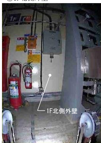
① 1F北側外壁
