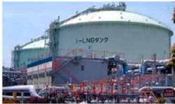
(写真：姫路LNG基地のLNGタンク 当社HPより)
