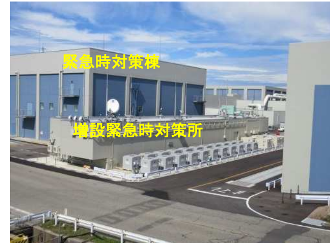
緊急時対策棟・増設緊急時対策所を 標高21m地点に建設
