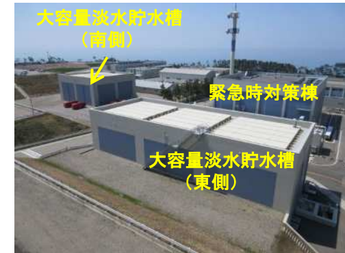
大容量淡水貯水槽 2基
