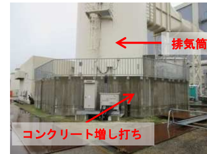
排気筒基礎部の補強
