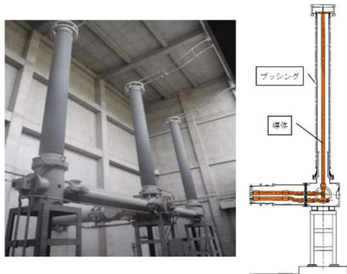
第 2.3 図 ブッシングの外観及び内部構造図
