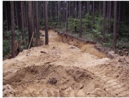
写真2 トレンチ全景 (北東端から撮影)
