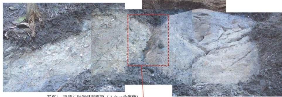
写真1 道清右岸側斜面露頭 (スケッチ箇所)
