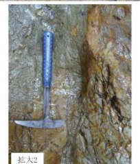
砂岩と泥岩の境界の断層面の連続性はやや不明瞭でしばしば分岐し、平面性は低い。また幅約5mmの砂礫岩を挟在しているが、粘土状破砕部を伴わない。 砂礫岩は、周囲の砂岩層と同様の固結の程度である。
