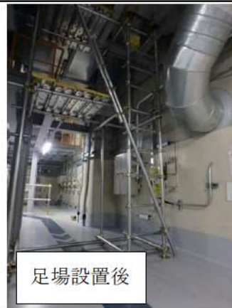
第2.1.2.8 図 アニュラス空気浄化システムにおける足場設置困難箇所及び足場設置モックアップ実施結果
