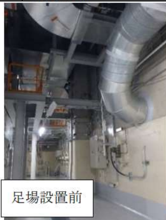
第2.1.2.8 図 アニュラス空気浄化システムにおける足場設置困難箇所及び足場設置モックアップ実施結果
