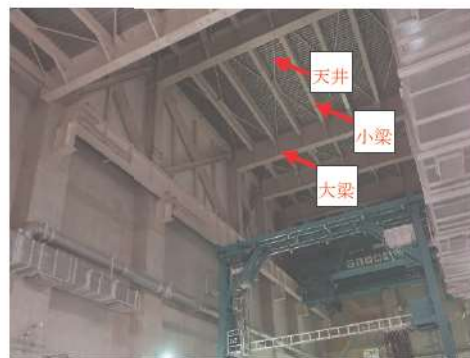
図 5.2.2 燃料取扱棟の屋根
