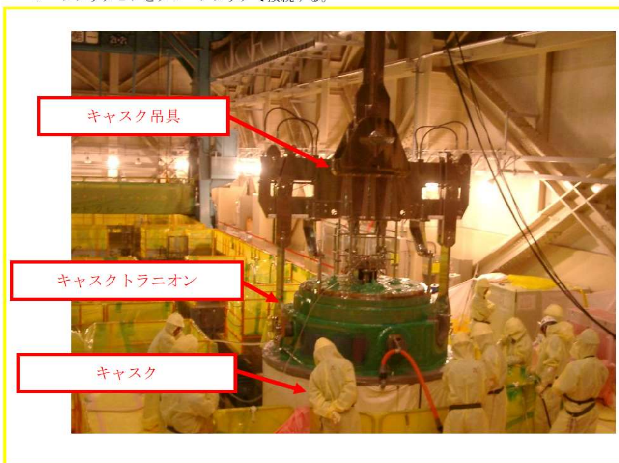
図1 キャスク吊具の現場での使用状況
