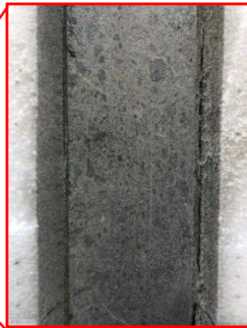
削孔開始から0.5m付近
