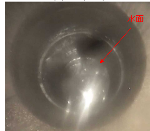
③RCW-Hx(C)入口(垂直)配管の水面
