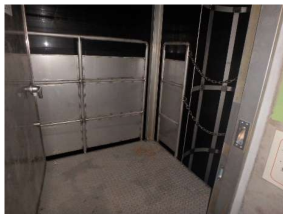
入口から見た足場（梯子昇降口）
