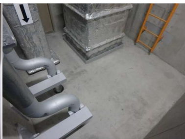
室内南西側から見た床面
