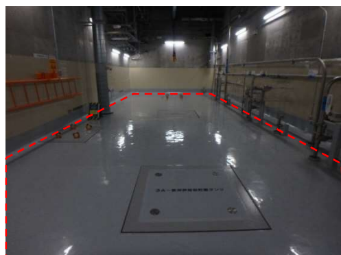
使用済樹脂貯蔵タンク上部バルブ室 (破線部の床下が使用済樹脂貯蔵タンク室)
