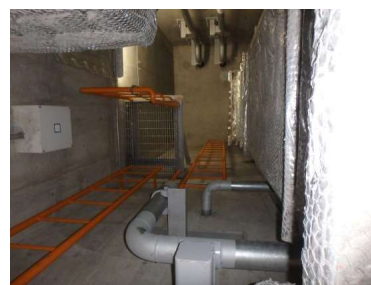
グレーチング上で西側を 向き見下ろした床面
