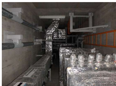
室内中央で北側を向き 見上げた天井
