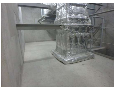
入口扉から見た床面
