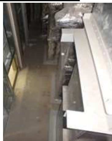
点検口を北側に見た床面
