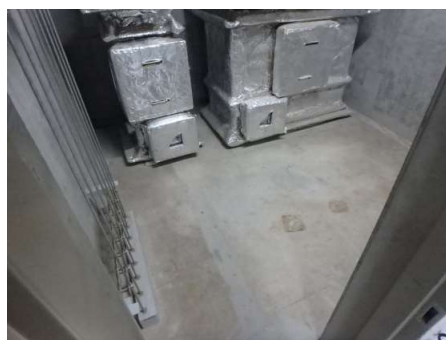
入口扉から見た床面
