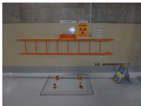
使用済樹脂貯蔵タンク室入口の コンクリートプラグ
