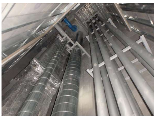
点検口を東側に見上げた天井
