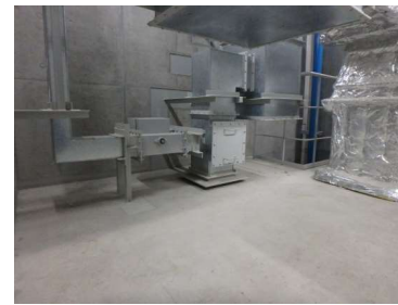
室内東側から見た床面
