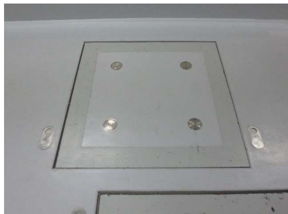
フィルタ室入口のコンクリートプラグ
