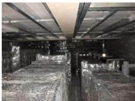
点検口より見上げた天井
