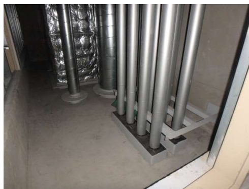
点検口から見た床面
