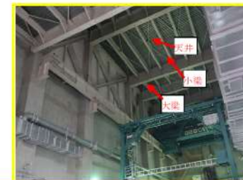
図5.2.2 燃料取扱棟の屋根
