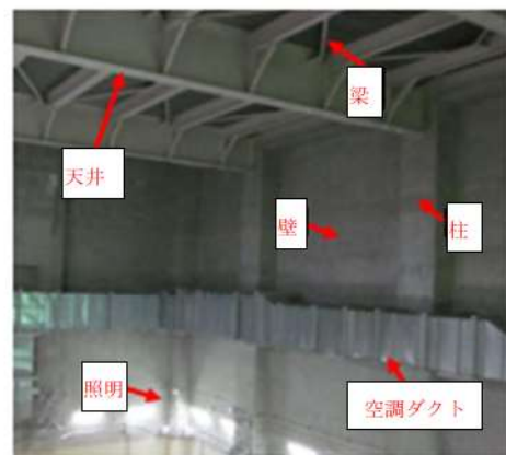
②使用済燃料ピット上部
