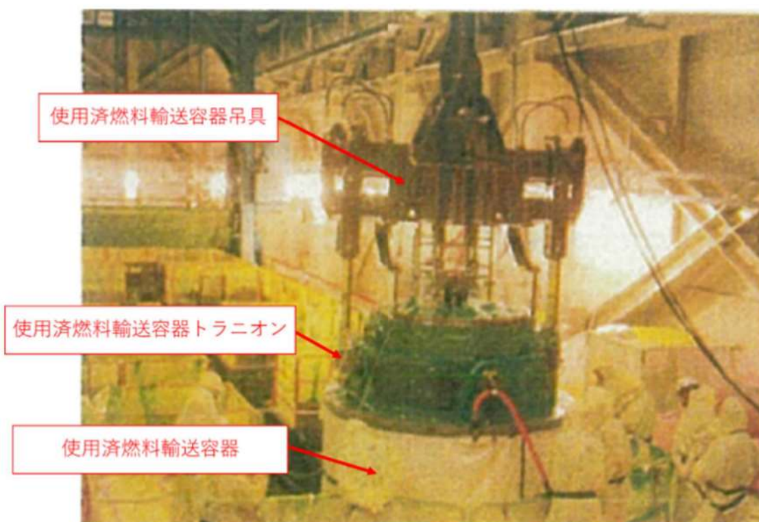
図1 使用済燃料輸送容器吊具の現場での使用状況
