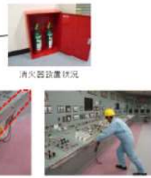
第 2.3-2 図 中央制御室における消火器及び手摺りの状況
